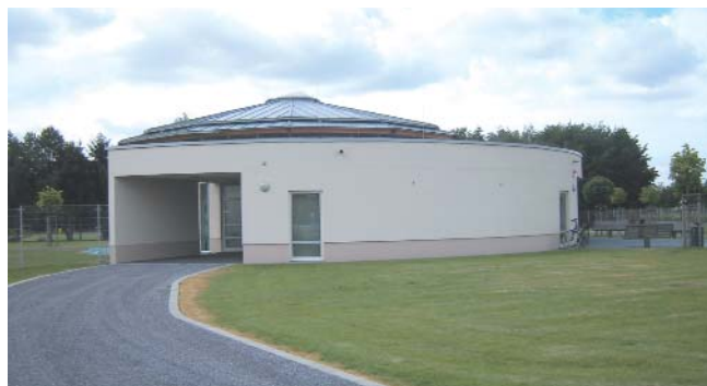
Die neue Totenhalle Holt erhöht die Kosten
