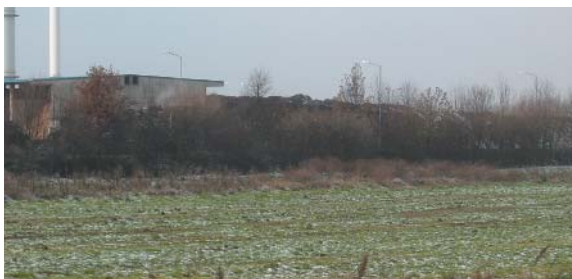
Auf diesem Feld neben der Kompostieranlage ist die Biogasanlage geplant
