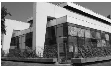
Soll abgerissen werden
